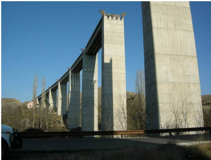
Слика 3-8 Недовршен мост во близина на станицата Кратово
