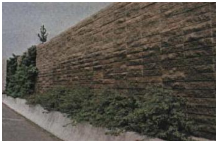
Фото.1 Зид кој варира во рамнински поглед, со цел да го редуцира ефектот на права линија и да обезбеди визуелен преглед
