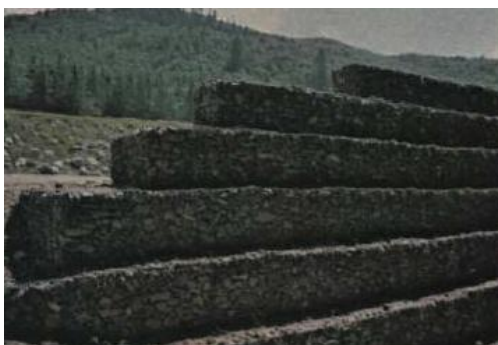
Фото. 5. Габионите можат да бидат наредени на различни начини за да создадат зид
