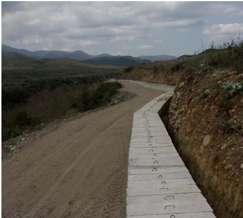
Фото 68. Новоизграден систем за наводнување што го пресекува израмнувањето за автопат Б (во близина на селото Миравци)
