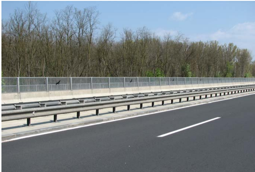
Фото 70. Заштитни панели за превенција на убивање на птиците за време на експлоатацијата на патот
