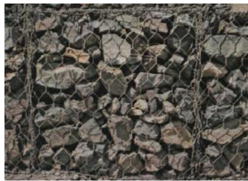
Фото. 3. Габионите се воглавно жичани корпи наполнети со камен
