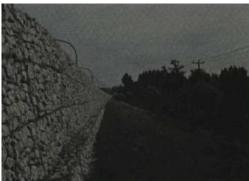
Фото.2. Зид за заштита од бучава составен од габиони
