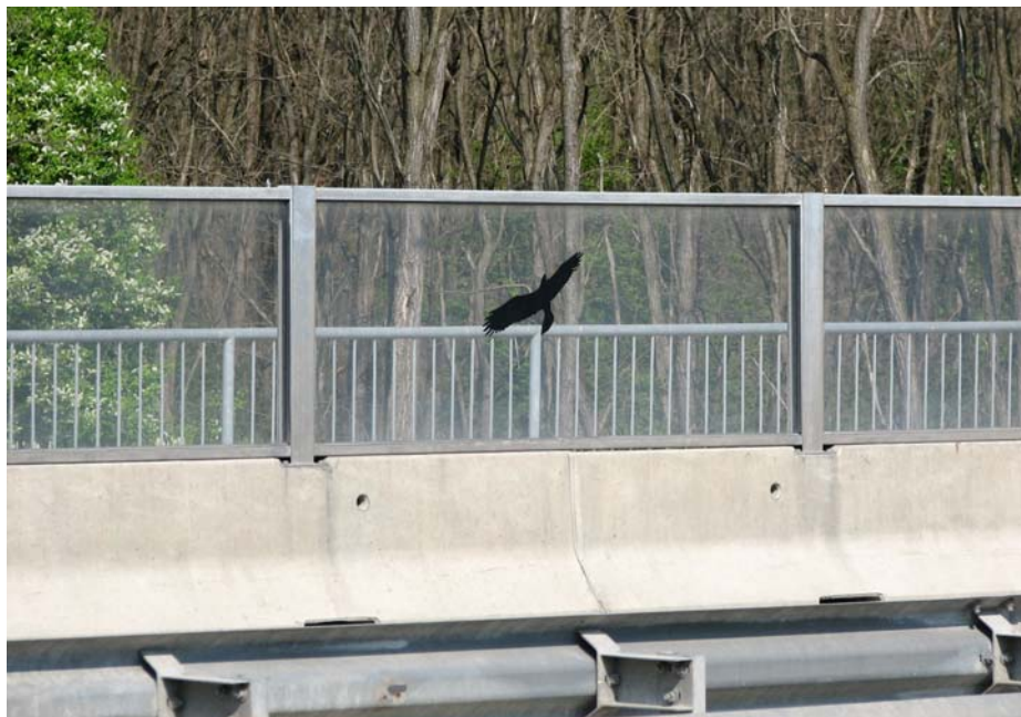
Фото 71. Детал од заштитните панели за превенција на убивање на птиците
