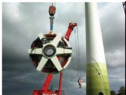
Слика 34 Транспорт и монтажа на ротор и перки
