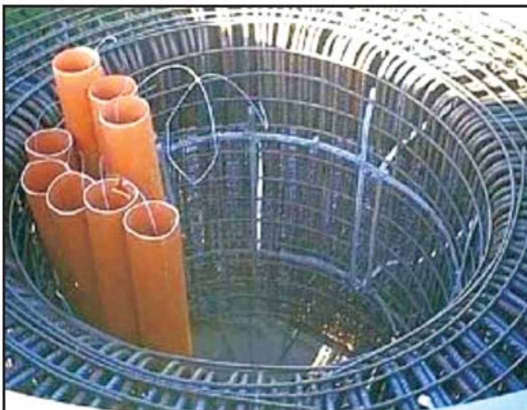
Слика 36 Изведено заземјување во процес на градба
