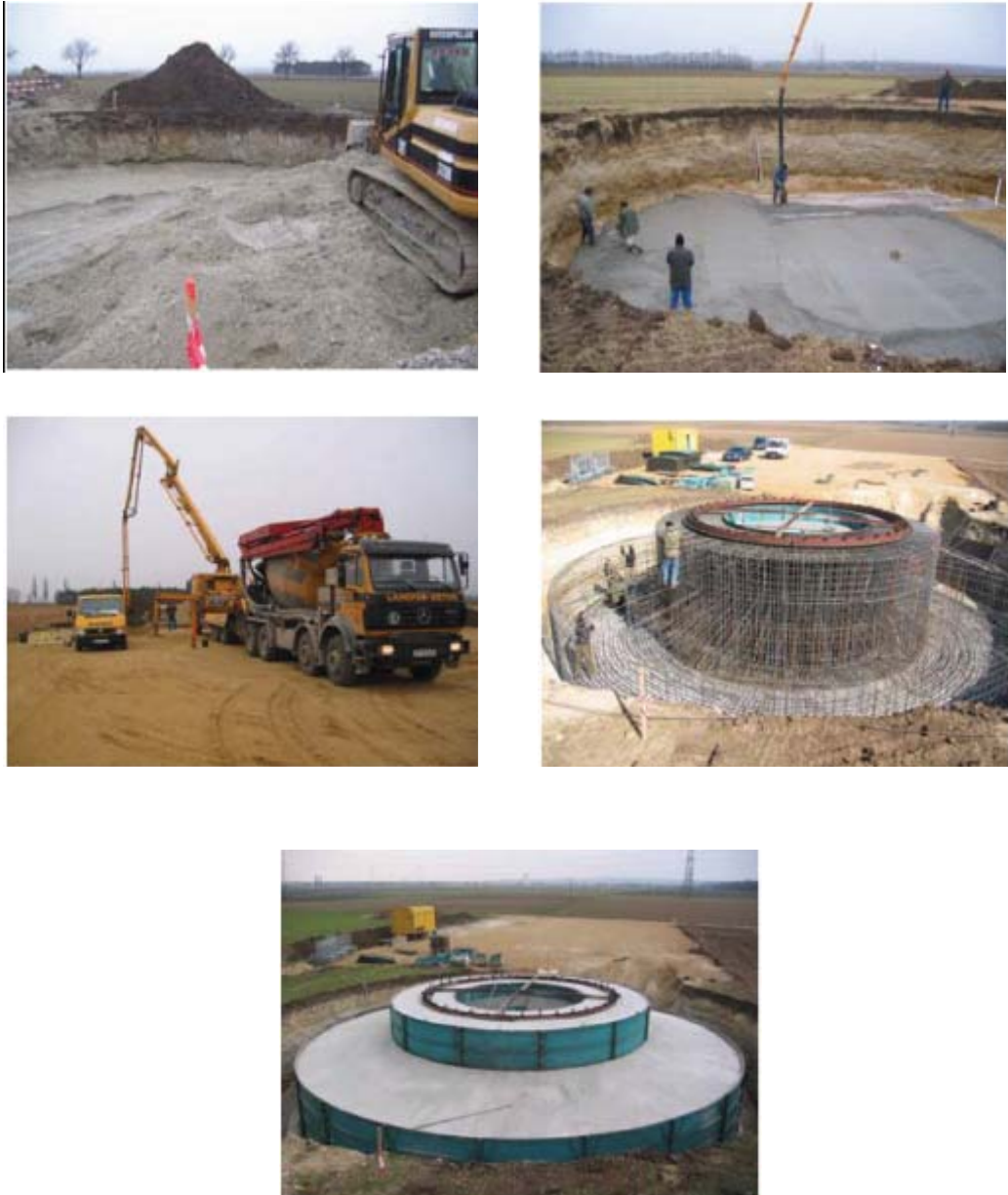
Слика 30 Поставување на фундамент на ветерна електрана
