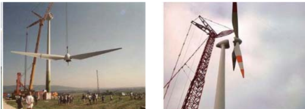
Слика 35 Транспорт и монтажа на ротор и перки
