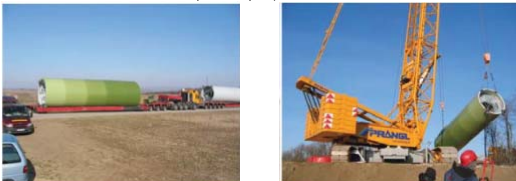
Слика 31 Транспорт и монтажа на цевната кула
