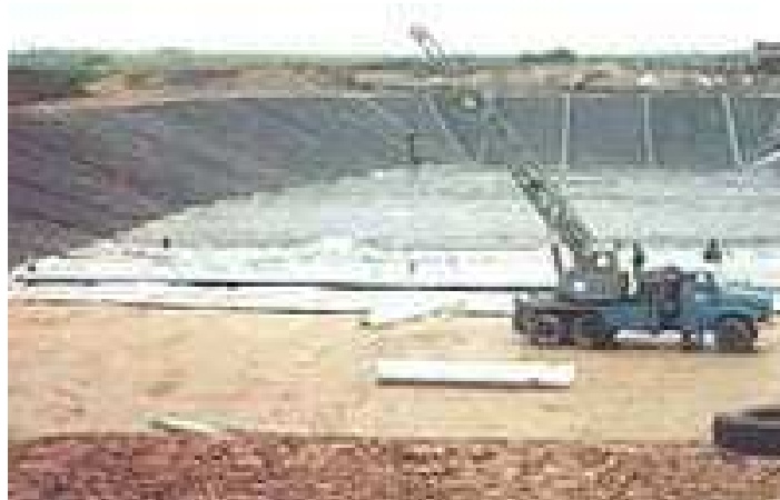
Слика Поставување на полимерната облога
