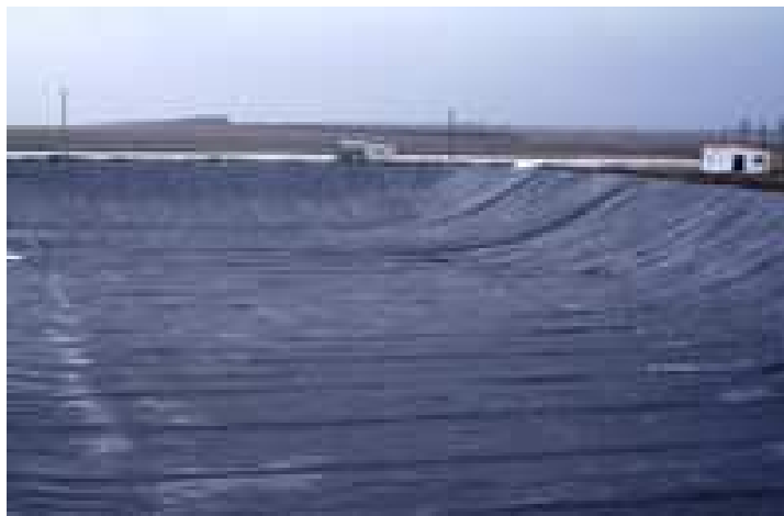
Слика Изглед на езеро за раствори подготвено со полимерна облога на дното
