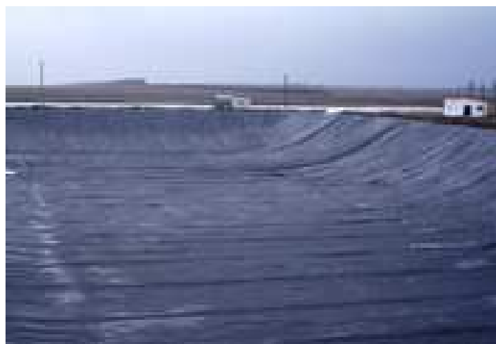
Слика - Езеро за раствори со полимерна облога на дното
