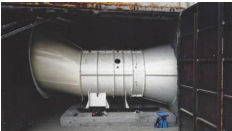
Слика 16 Вентилатор од типот Зитрон
