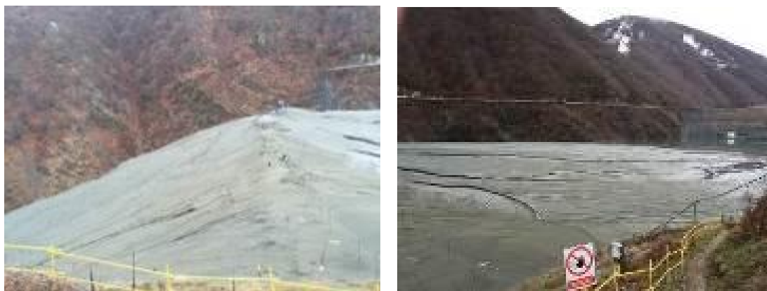
Слика 14 Активно хидројаловиште бр.3-2 (Песочна брана и таложно езеро)
