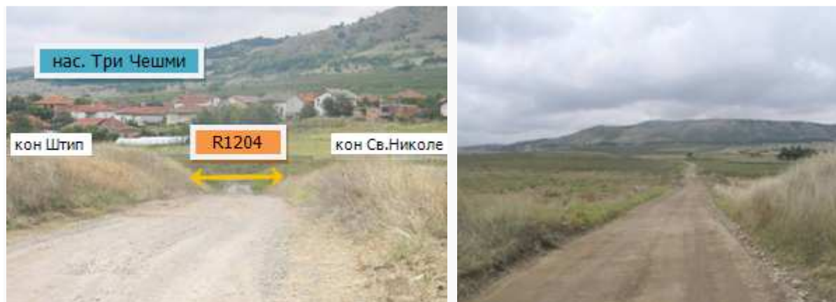
Слика Пристапен пат до локацијата на асфалтната база на SINOHYDRO Co LTD
