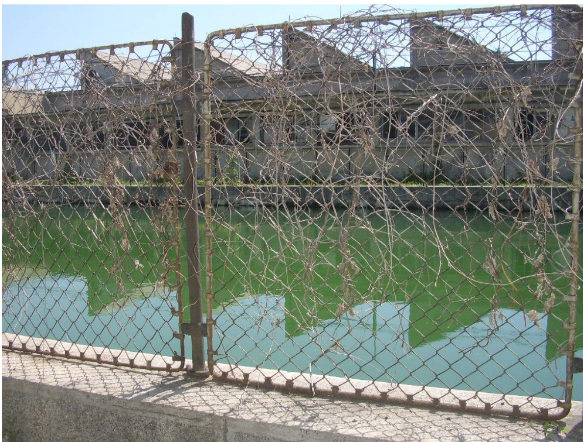
Слика 5 Базен за собирање на отпадната вода од технолошкиот процес во кругот на фабриката
