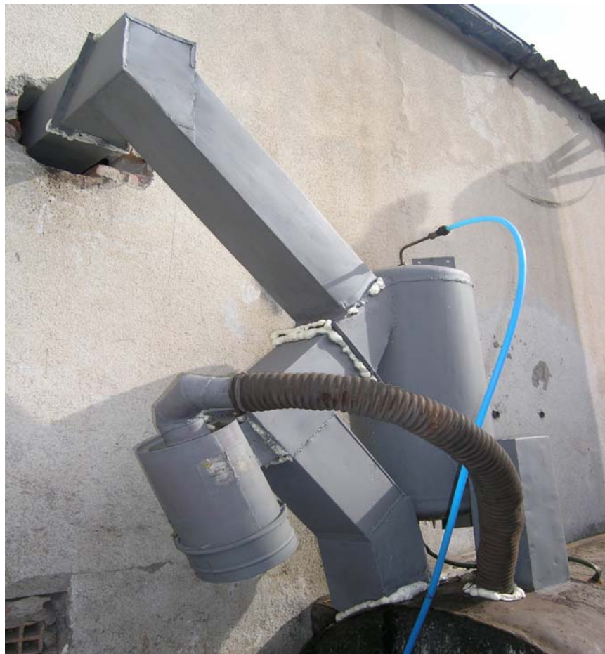
Сл. бр. 7 Воден филтер за пречистување на зафатениот воздух над печките
