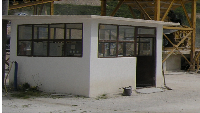
Слика 15. Контролна кабина
