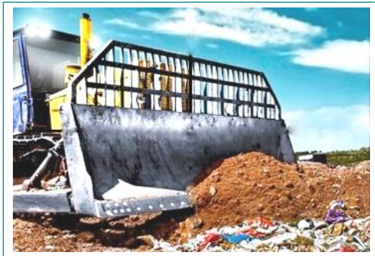
Слика бр.V-3: Формирање на покривен слој од земја со помош на булдозер
