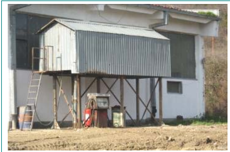
Слика бр.V-7: Пумпа и резервоар за гориво Д2
