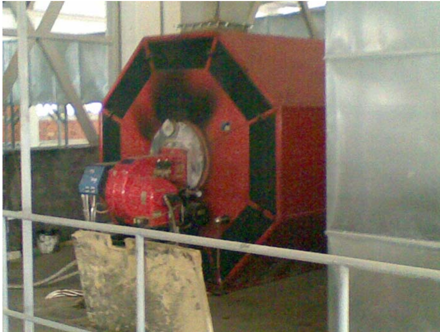
Слика 6 Котел (печка) за делумно загревање
