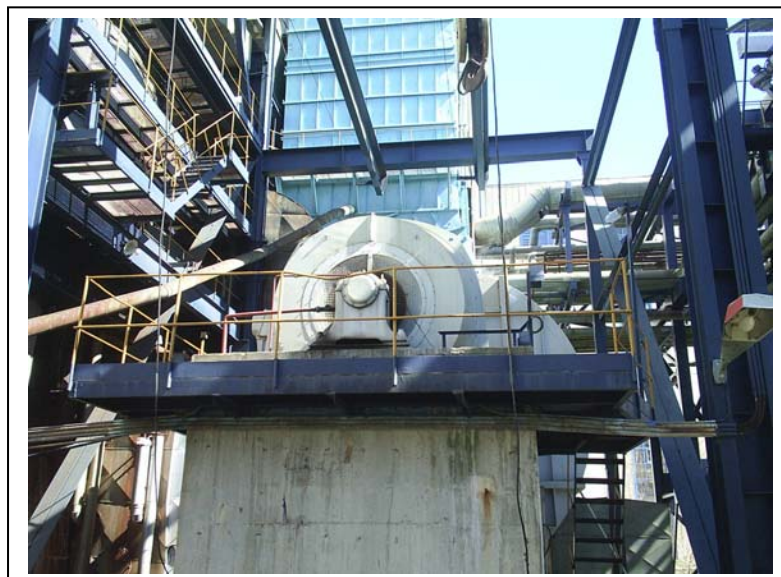
Слика бр. IX-4 : Електромотор од вентилатор - извор на бучава
