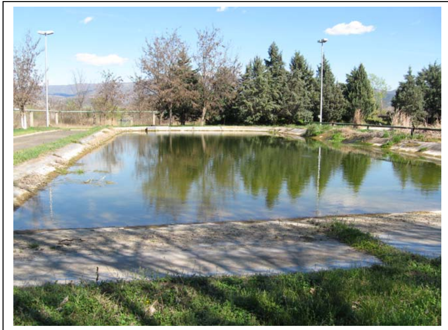
Слика бр. VIII-8 : Базен за прочистена фекална вода
