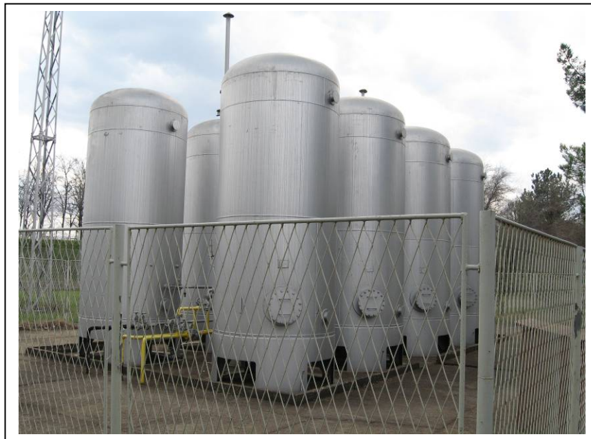
Слика бр.П-26 : Резервоари за H_2 и CO_2
