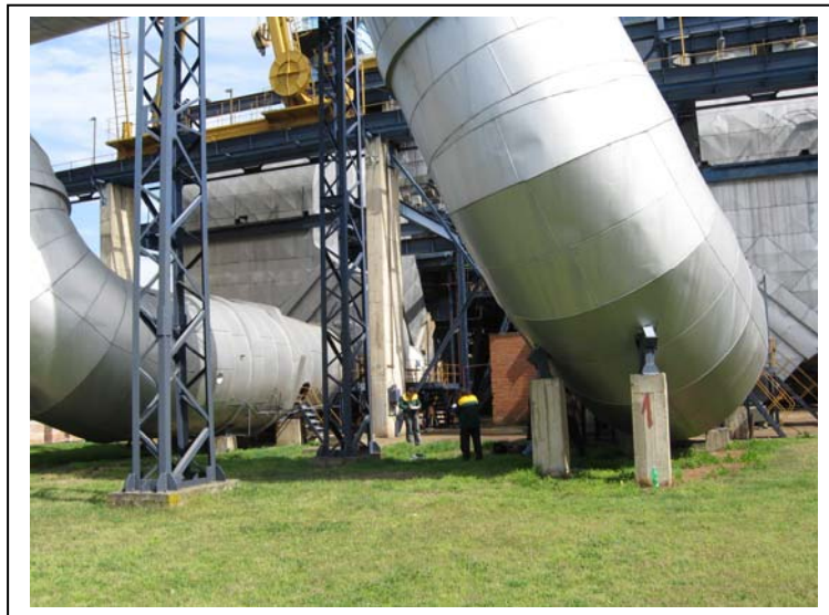
Слика бр.IX-1 : Издувни канали со мерни места
