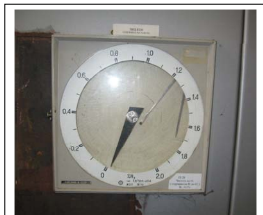
Слики бр. VIII-3 и бр. VIII-4 : Инструменти за мерење на % на H 2 и O 2
