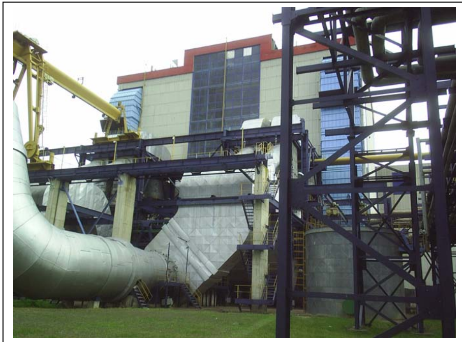
Слика бр.П-16 : Надворешен изглед на котелската постројка
