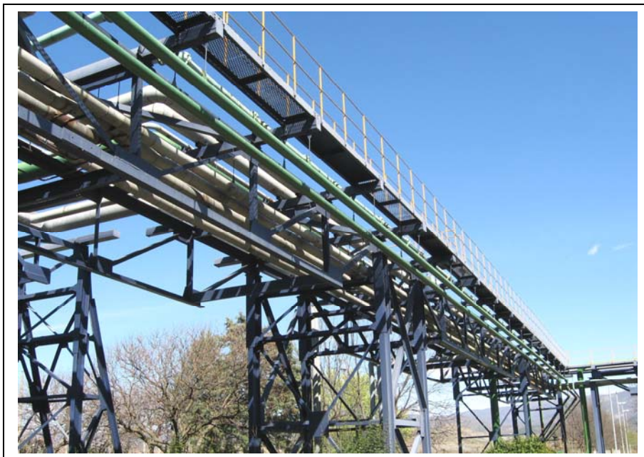
Слика бр. V-7 : Цевен мост
