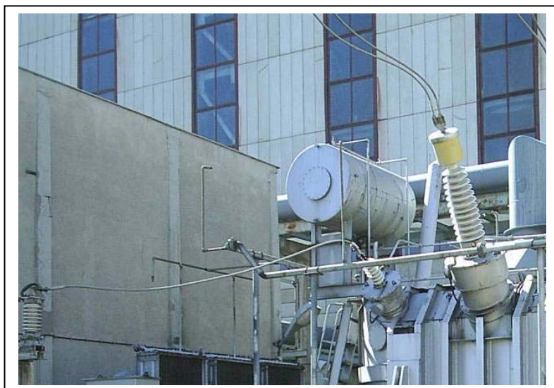
Слики бр. XII-3, бр. XII-4 бр. XII-5 : Сплинкер системи за гасење (ладење)
