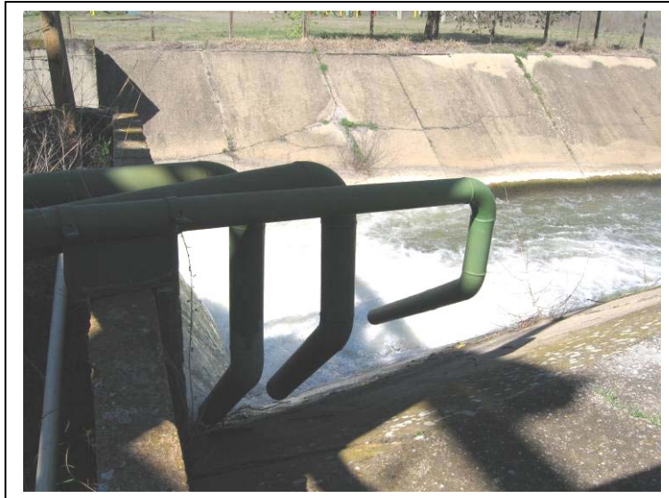
Слика бр. VI-4: Испусци на неутрализирана вода во одводниот канал
