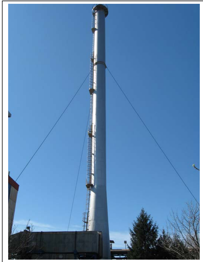
Слика бр. VI-3: Оџак на стартен (помошен) котел
