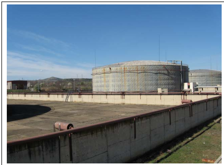
Слика бр. V-5 : Заштитни базени на резервоарите за мазут
