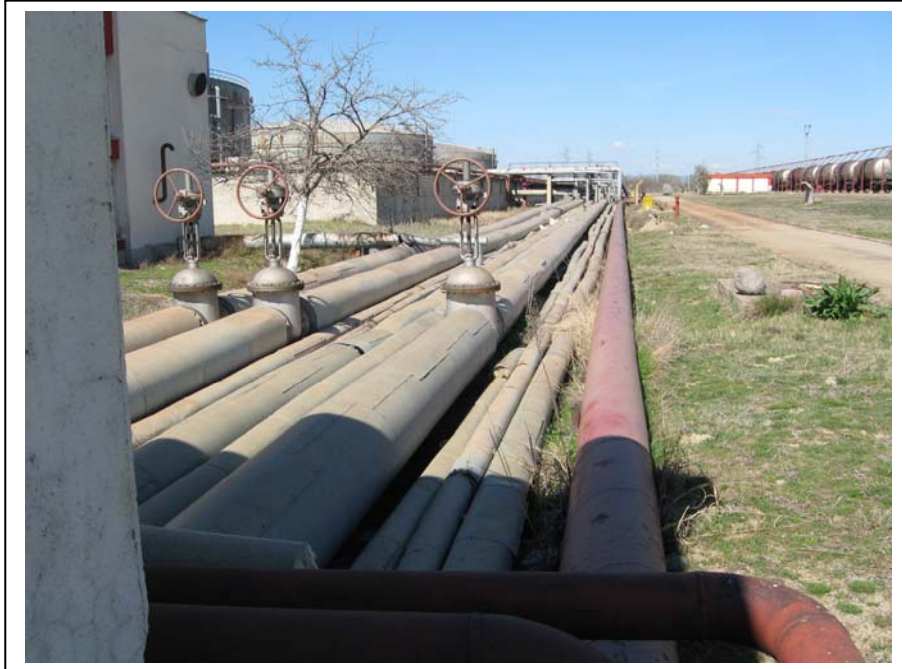
Слика бр.V-6 : Надземен цевоводен развод за горива
