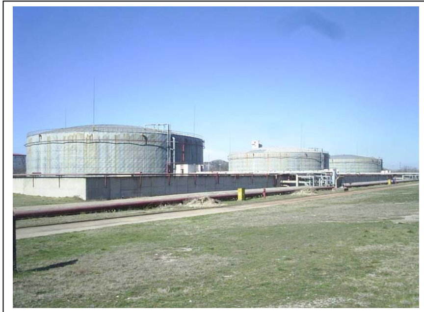
Слика бр. V-4 : Резервоари за мазут
