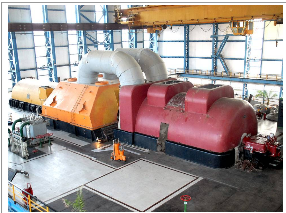
Слика бр.П-21 : Турбогенератор
