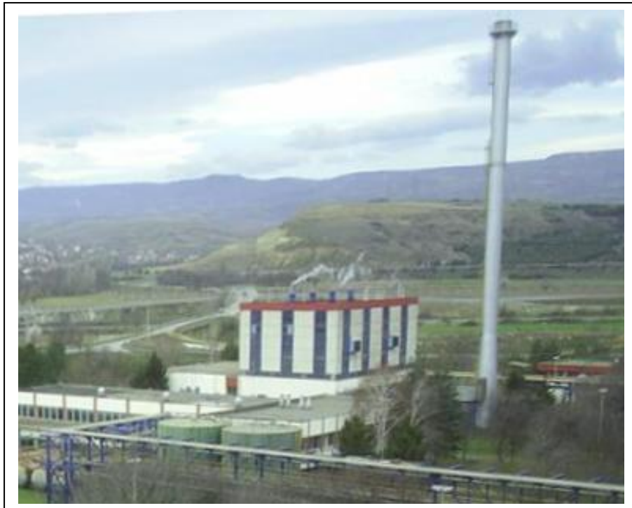
Слика бр. II-15 : Помошна котлара
