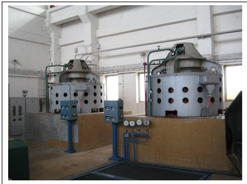
Слики бр.П-9 : Пумпи за разладна вода
