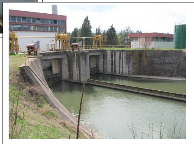
Слики бр.П-6 и бр.П-7 : Зафатна градба за разладна вода
