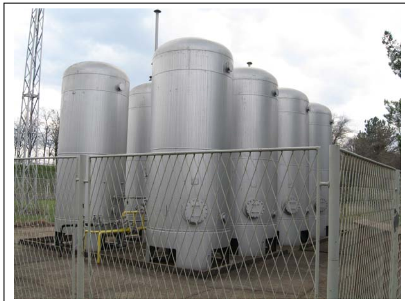
Слика бр. XII-9 : Заштитна ограда околу складот за H 2 и CO 2
