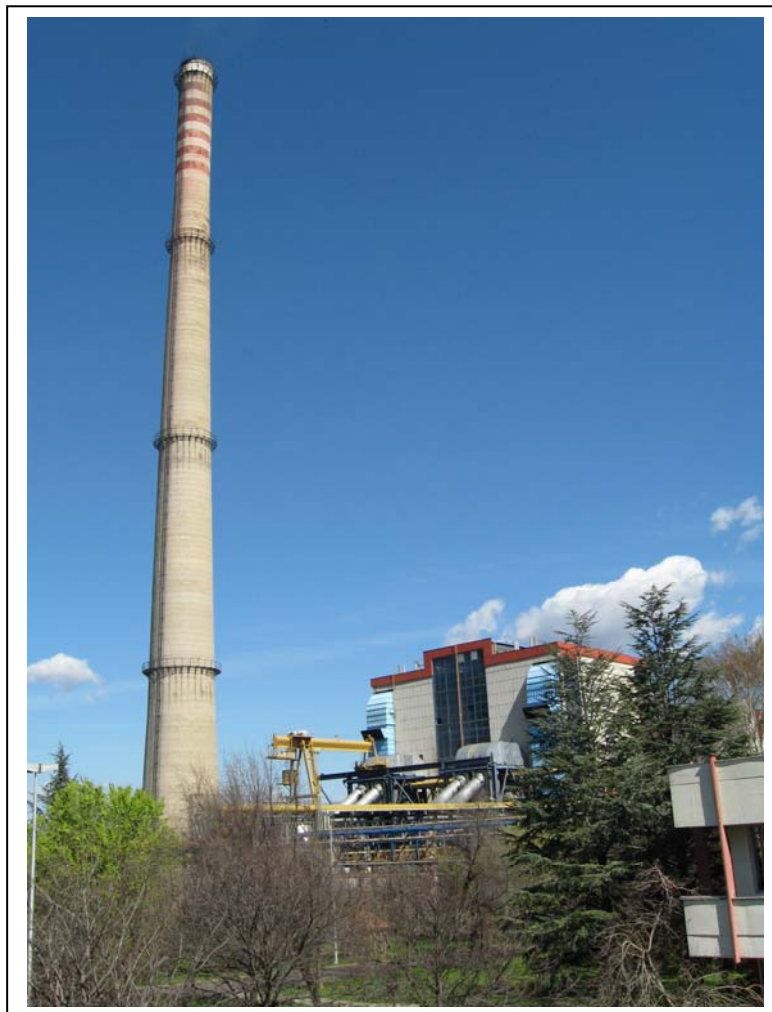
Слика бр.VI-2: Оџак на главен котел
