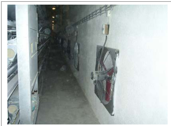
Слика VI.1.2-1 и VI.1.2-2: Вградени вентилатори и надворешни прозори со капацитет
