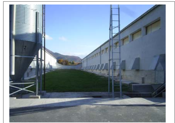
Слика VI.1.2-1 и VI.1.2-2: Вградени вентилатори и надворешни прозори со капацитет
