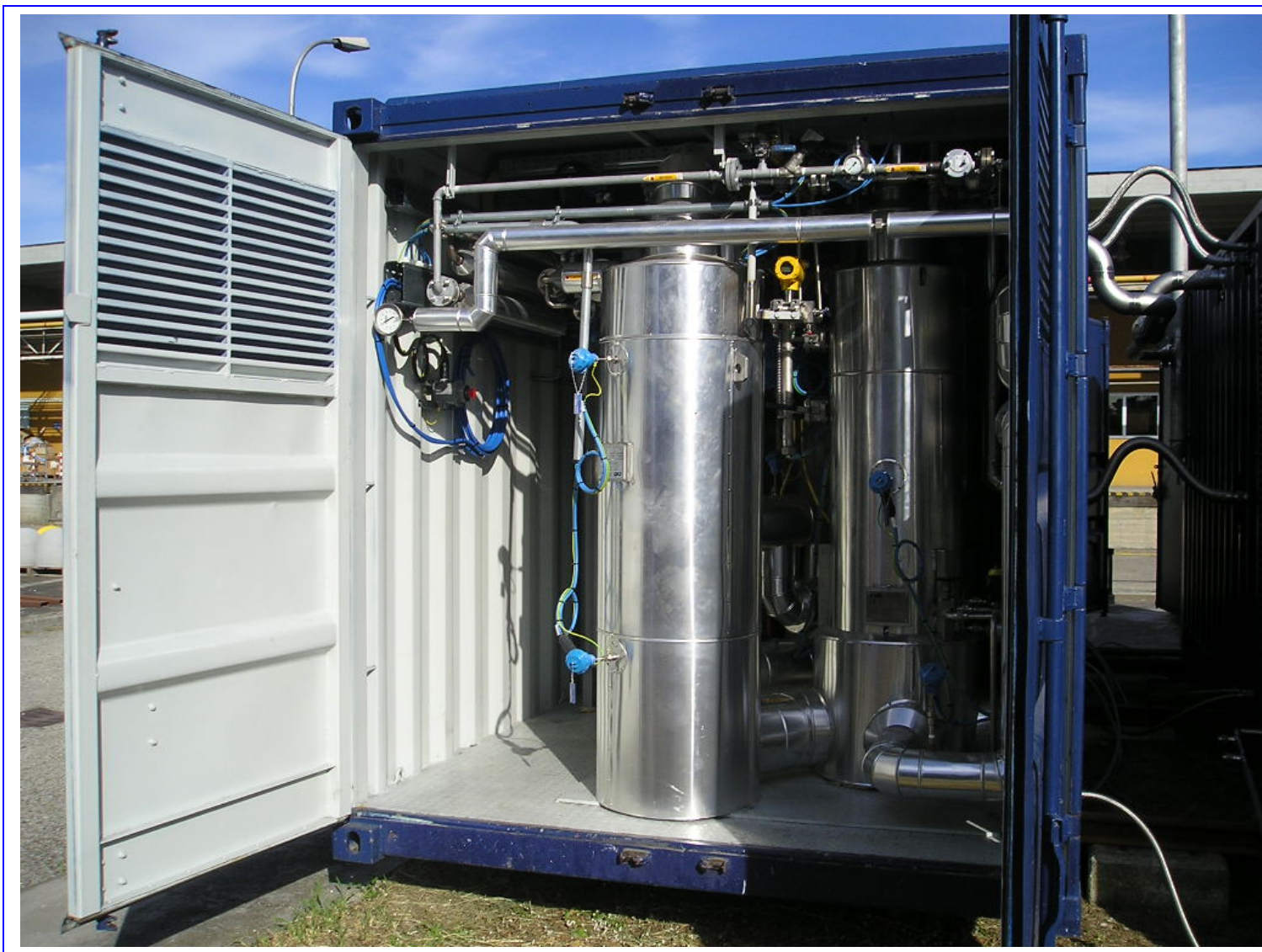
Слика бр.ИИ-6: Изглед на опрема за производство на гасен водород
