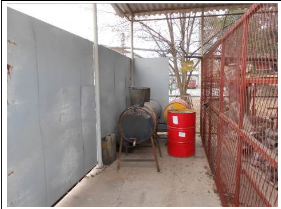
Слика бр.V-12: Внатрешен изглед на објектот за одлагање на опасен отпад (употребено масло од компресорски единици)
