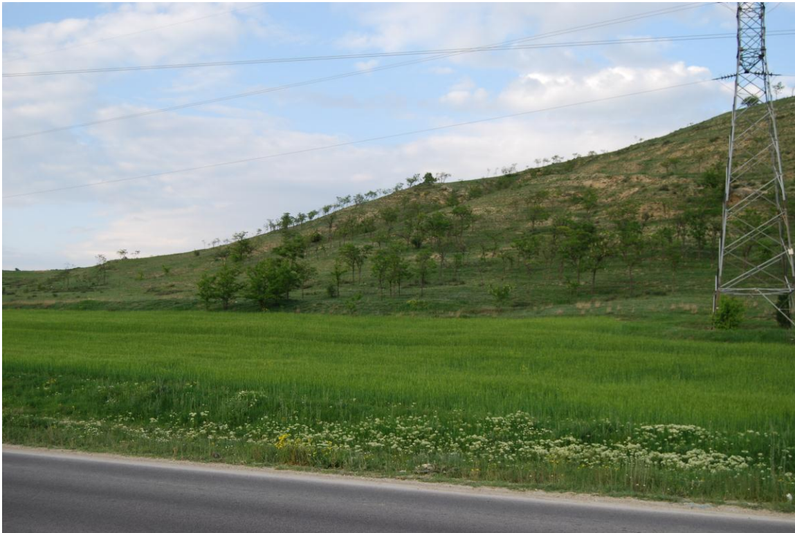
Фотографија б: Користење на багрем за заштита од ерозија на дел од траса на излез од Свети Николе
