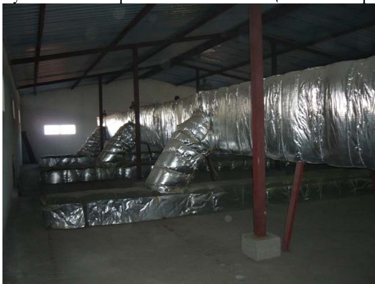
Слика бр.5 Довод и одвод на воздух во сушари
