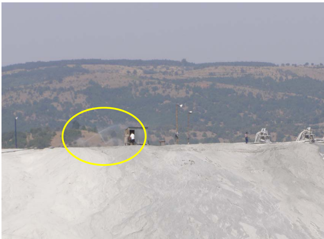
Сл. 8.1.1 Оросување на дел од сувата површина на хидројаловиштето
