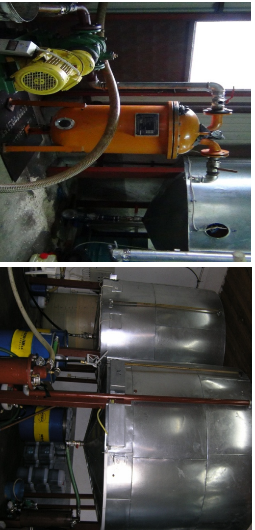
Слика. 7 Преточување на отпадно масло од резервоар во метално буре
