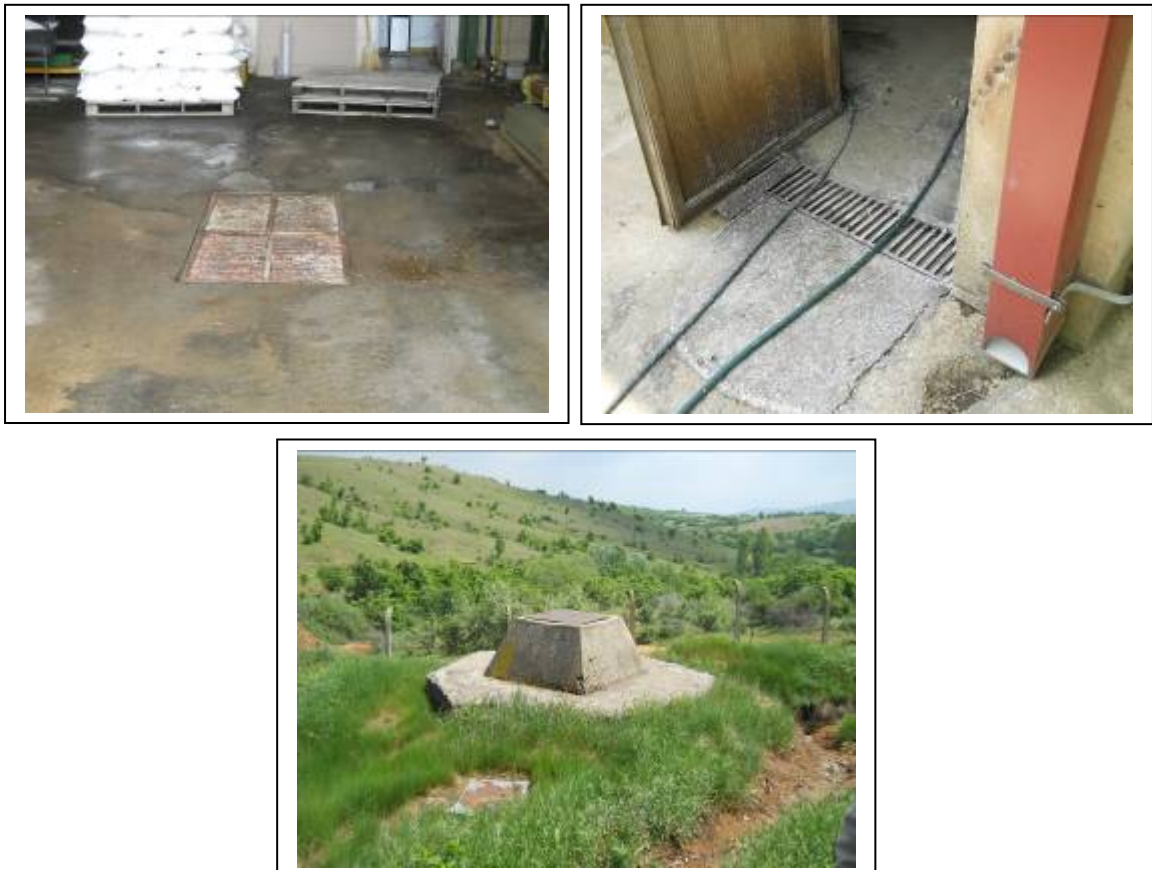
Слика V - 2, 3 и 4: Сливници со решетки и јама за отпадна вода
