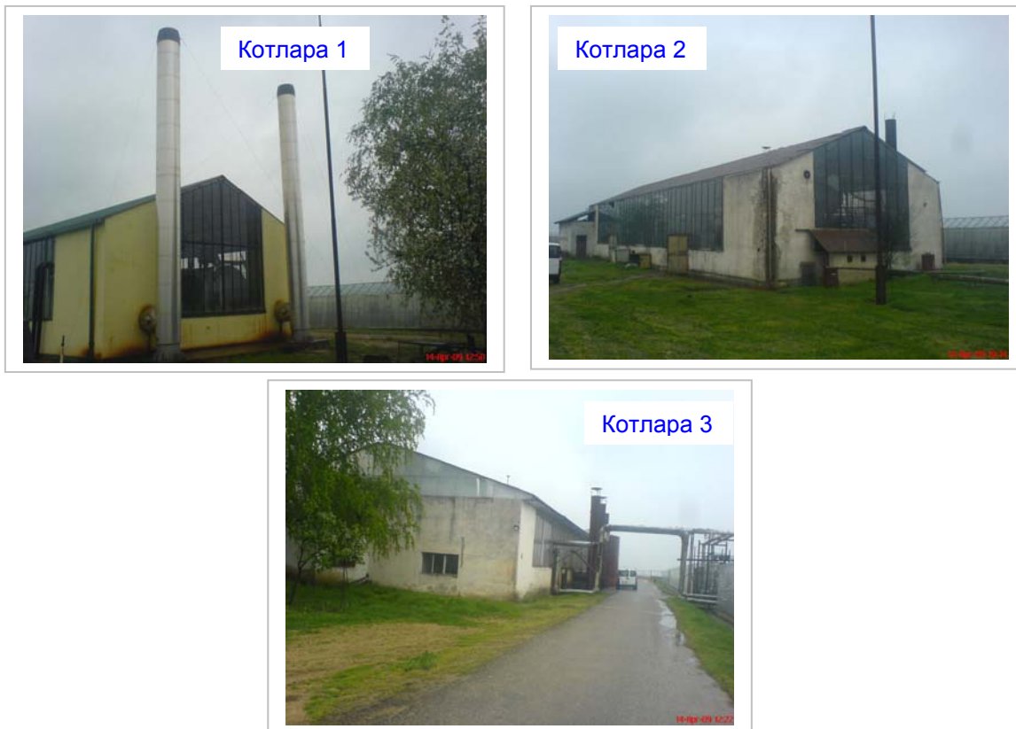
Слика II.2.3.2-1: Котлара 1, котлара 2 и котлара 3
