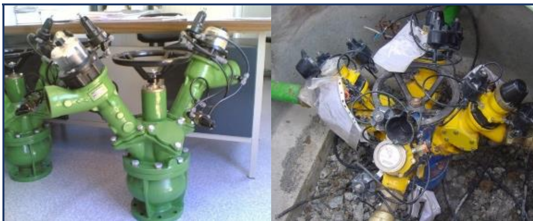
Слика 12 Приказ на хидрант со два приклучоци и хидрант со четири приклучоци (веќе инсталиран)
