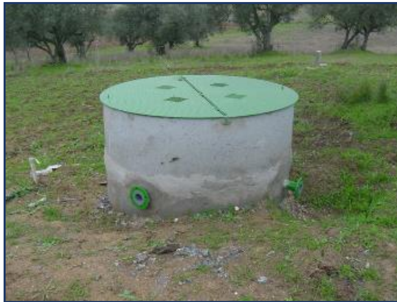
Слика 13 Заштитна шахта за хидрант за наводнување
