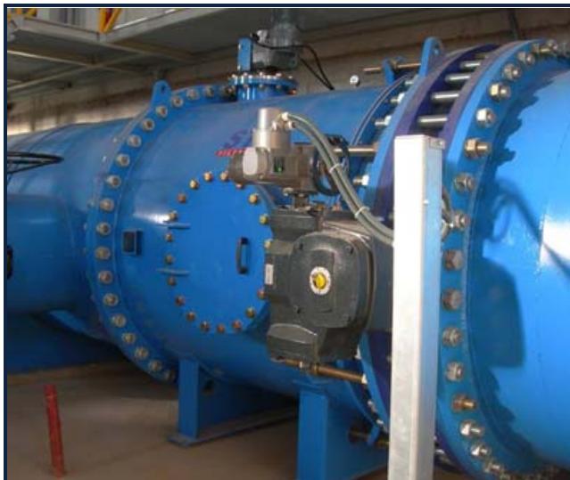
Слика 15 Филтер (Screen filter) поставен по должина на цевководот
