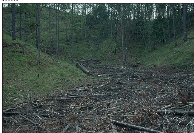
Слика 40 Примена на гранки за спречување на ерозијата покрај градилиштето
