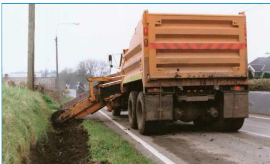
Figure 44 Изведба на отворен канал на подрачја каде трасата се води во мал усек
