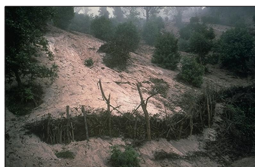
Figure 39 Примена на бариери за спречување на ерозија од терен нападната со градежни работи
